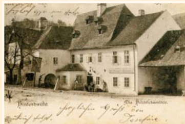
die alte Höldrichsmühle
